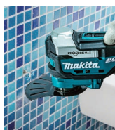
Encaje de juntas en revestimiento cerámico.
