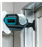
Retirada del marco de ventanas.
