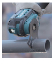
Corte de tubos de PVC.
